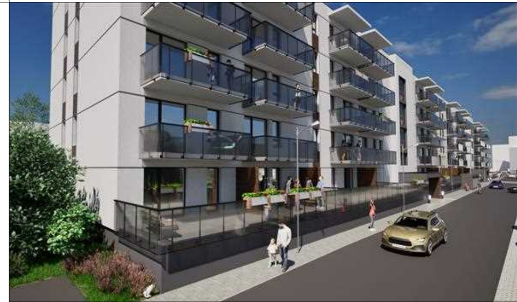
LOKALIZACJA W BUDYNKU
