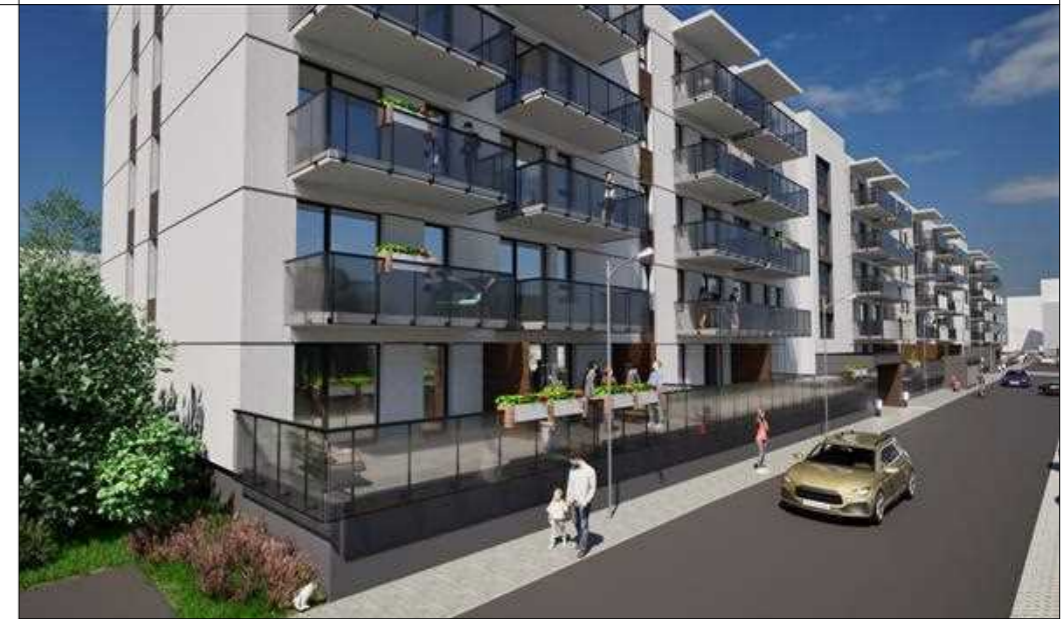
LOKALIZACJA W BUDYNKU
